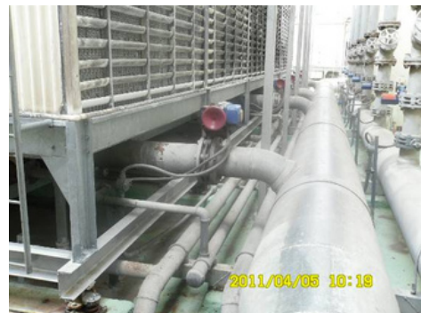
โครงสร้างหอระบายน้ำ
