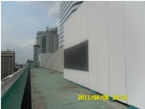
ผนังด้านข้างอาคาร
