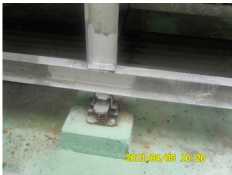
ฐานรองรับหอระบายน้ำ
