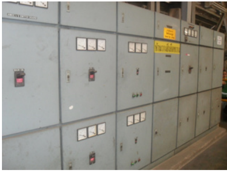
ตรวจสอบห้องควบคุมไฟฟ้าหลัก
