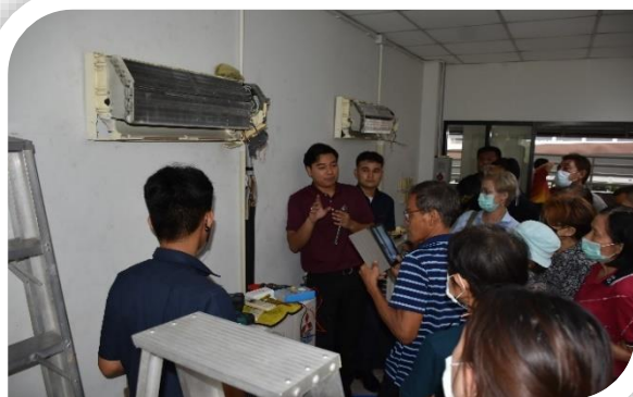
การตรวจเช็คเครื่องปรับอากาศ
