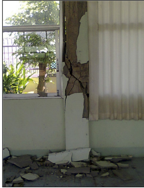
อาคารที่เสียหายจากช่องเปิดที่ไม่เหมาะสม
