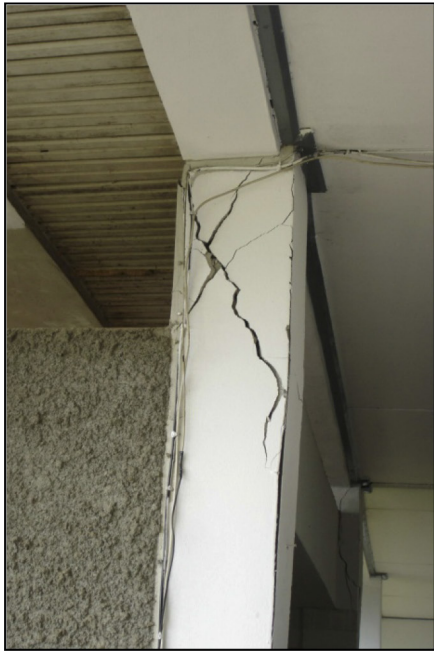
อาคารที่เสียหายจากช่องเปิดที่ไม่เหมาะสม
