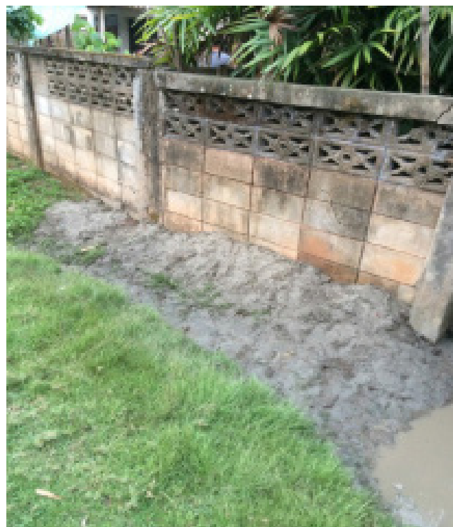
รูปที่ 5 ปรากฏการณ์ทรายเหลวจากเหตุการณ์แผ่นดินไหวในจังหวัดเชียงราย เมื่อวันที่ 5 พฤษภาคม 2557
