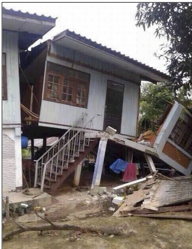
รูปที่ 10 ตัวอย่างอาคารที่มีชั้นที่อ่อนบริเวณชั้นล่างเปิดโล่งและพังทลายจากเหตุการณ์แผ่นดินไหวในจังหวัดเชียงราย เมื่อวันที่ 5 พฤษภาคม 2557
