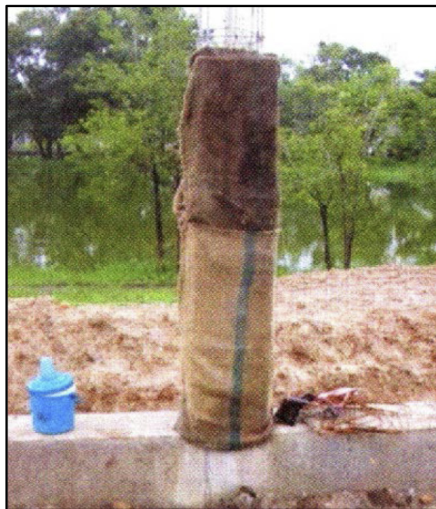
รูปที่ 23 การบ่มเสาคอนกรีตเสริมเหล็กโดยการใช้ผ้ากระสอบชุบน้ำคลุมรอบ
